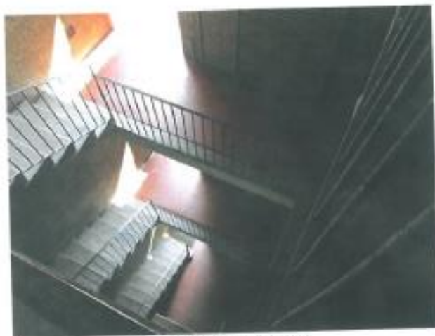
stato di fatto vano scala
