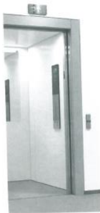
Pareti ascensore: Lino Fiandre, Acciaio lavorato antigraffio. Specchio
